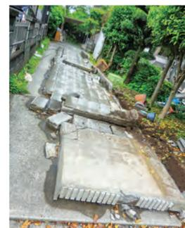
地震で倒壊したブロック塀(熊本市)
