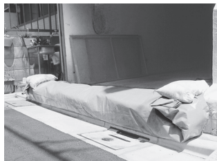
▲土のうの設置例
