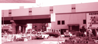
(右)工事中の西葛西駅 昭和54年ころ
