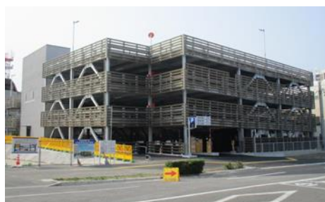
来庁舎用立体駐車場（山口県宇部市）
