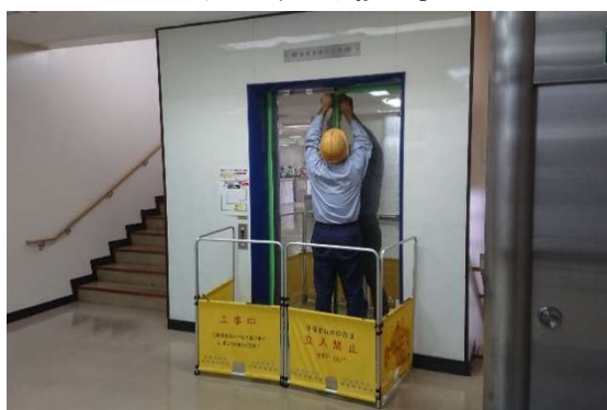
エレベーター改修工事
