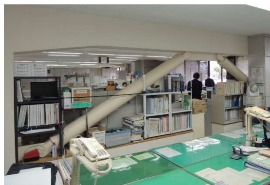
耐震補強の状況
