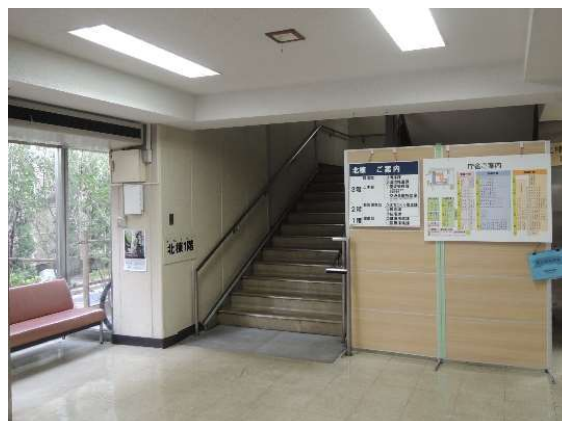
北棟の階段（エレベーター未設置）
