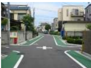
▲道路整備（南小岩七・八丁目地区） 幅員約2.7～3.6mから6mに拡幅
