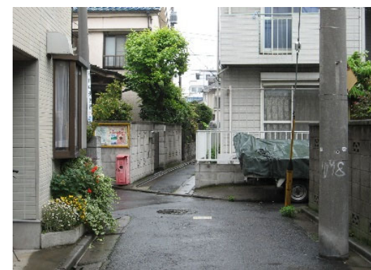
道路整備（南小岩七・八丁目地区） 幅員約 2.7~3.6m から 6m に拡幅
