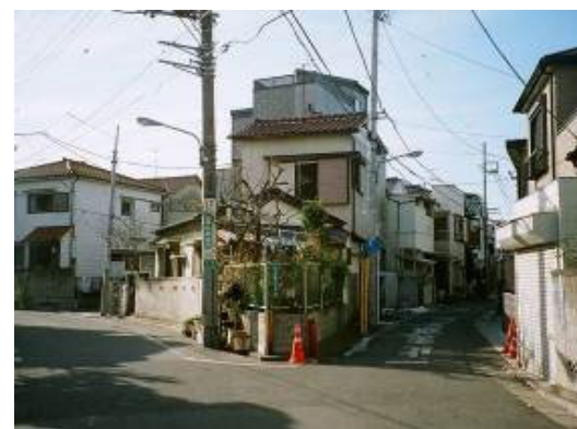
道路整備（松島三丁目地区） 幅員約 3.6m から 6m に拡幅
