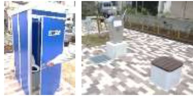
防災井戸とトイレスツール
