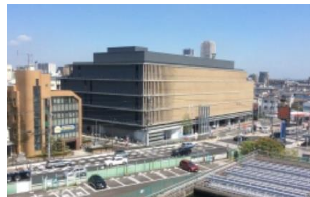
新第2庁舎の外観（出所：市川市HP）
