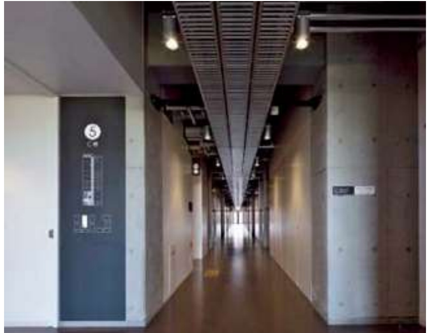
広島県三原市（出所：三原市公表資料） 保全・更新作業に配慮し、通路天井に 設置した配線ラック
