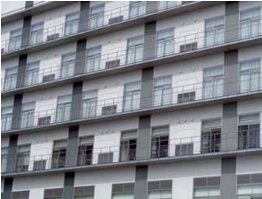
広島県三原市（出所：三原市公表資料） 保全・更新作業に配慮したメンテナンス バルコニー
