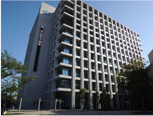
■浦安市役所の全景
