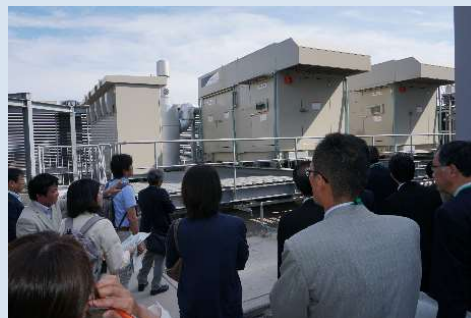
■発電機等の設備（屋上）
