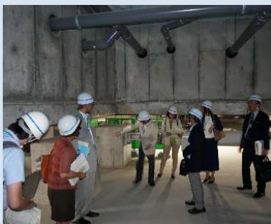
■免震装置（地下）
