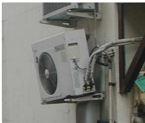
外れそうなエアコン室外機
