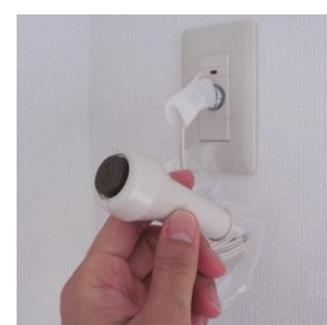
緊急通報装置
