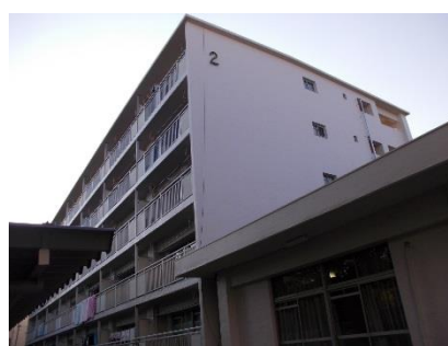
「中葛西四丁目アパート」外装塗装工事 (平成29年度)
