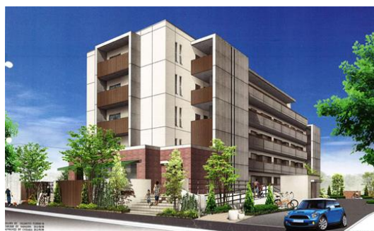
子育て支援住宅 「BRICK&WOOD」（船堀地区）
