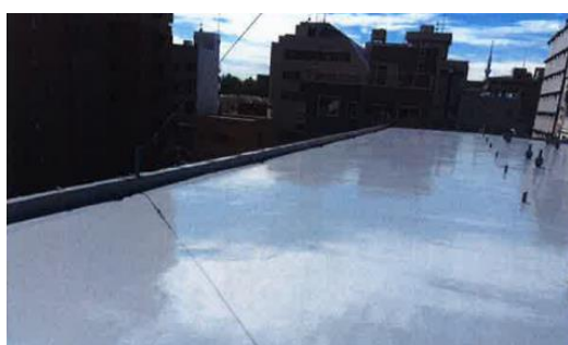
「江戸川中央一丁目第2アパート」屋上防水工事 (平成28年度)
