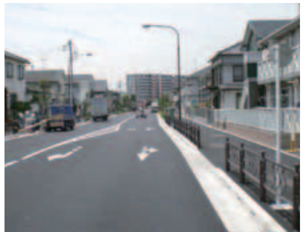
【電線類の地中化】
