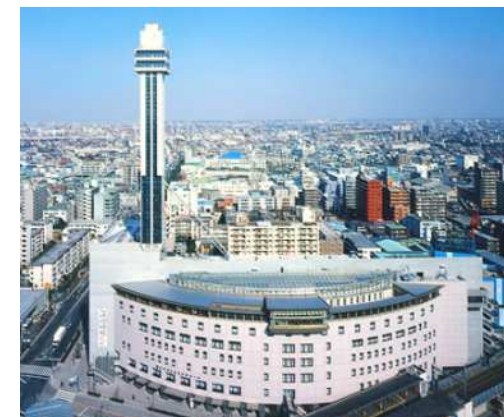
タワーホール船堀
