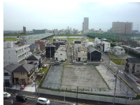
造成完了後の宅地利用
