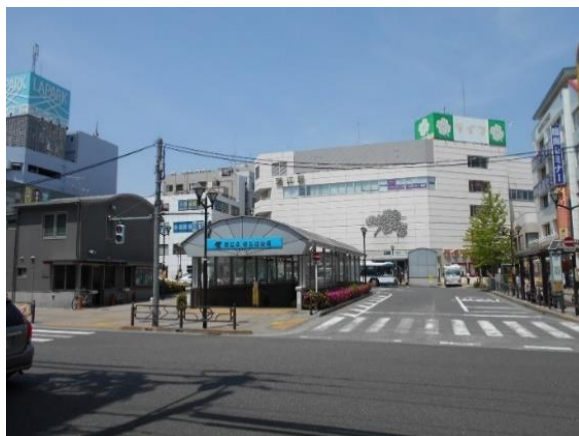
土地区画整理事業で整備された瑞江駅周辺
