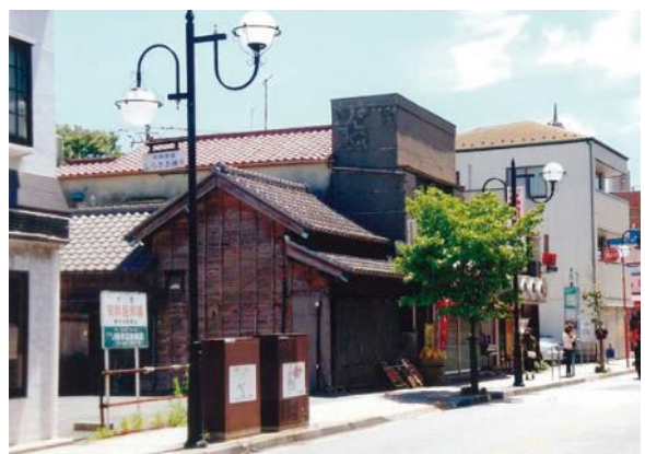
無電柱化した今井街道（はなみずきロード）
