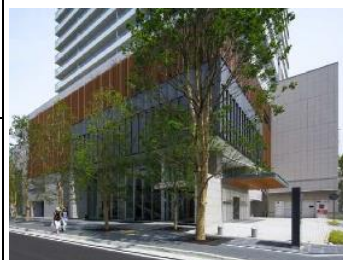
落ち着いた色彩とした低層部の外壁
