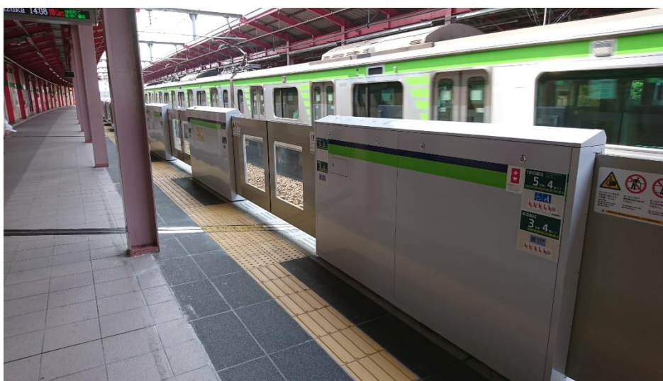
ホームドアの設置例（船堀駅）
