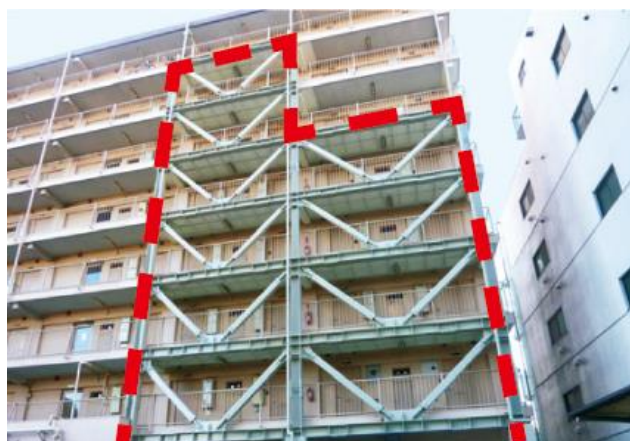
マンションの耐震化（鉄骨による補強）
