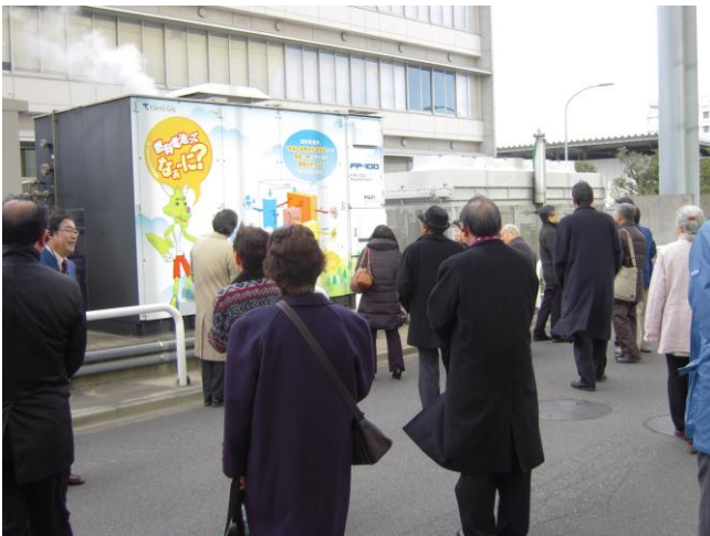
燃料電池（出力：100KW）
