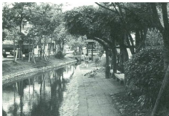
古川親水公園完成時 (昭和48(1973)年7月)
