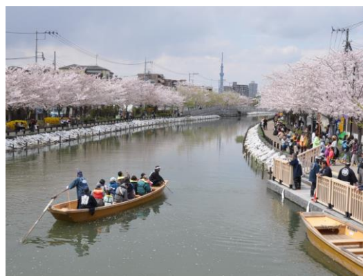
整備後の新川
