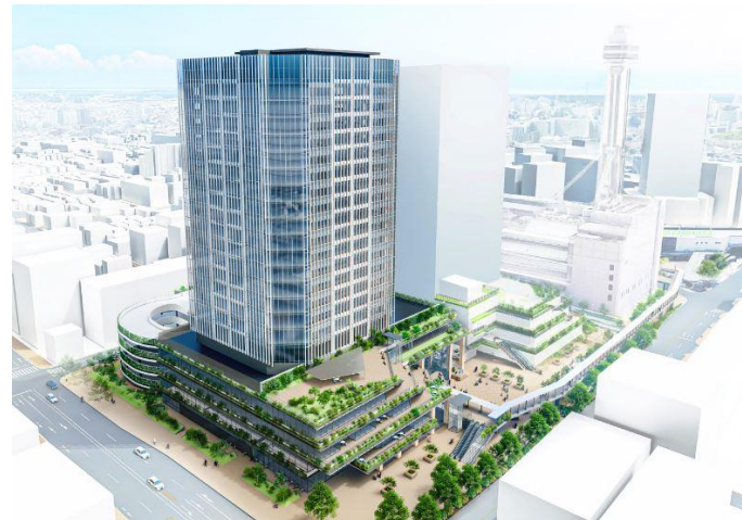
新庁舎の建設
