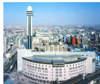
タワーホール船堀
