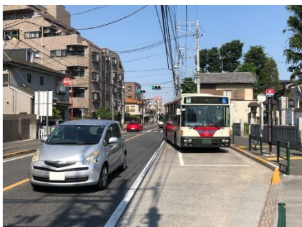
図 3-9 バス停留所（バスベイ）の設置例
